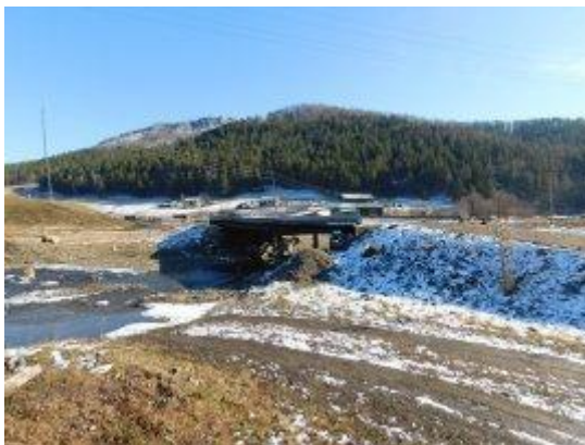
Рис. 8.- Автомобильный мост через р. Уйтушкен на ул. Чичкинская с. Бешпельтир Бешпельтирского сельского поселения
