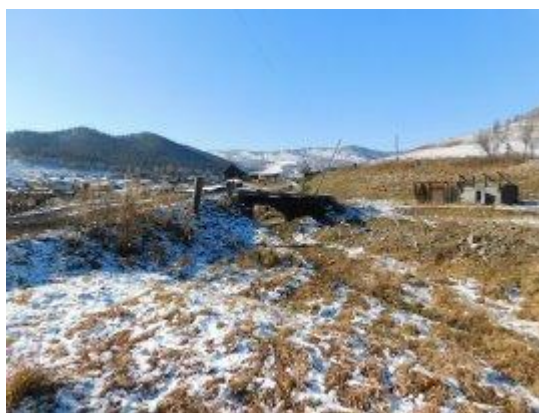
Рис. 9.- Автомобильный мост через р. Чичка на ул. Чичкинская с. Бешпельтир Бешпельтирского сельского поселения
